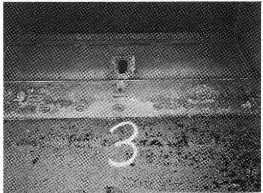
写真15 加熱後の加熱面側の状況 (ダンパー内の接合部) 試験体番号 3
