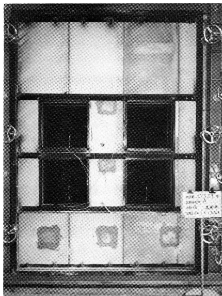
写真6 加熱後の裏面側の状況
