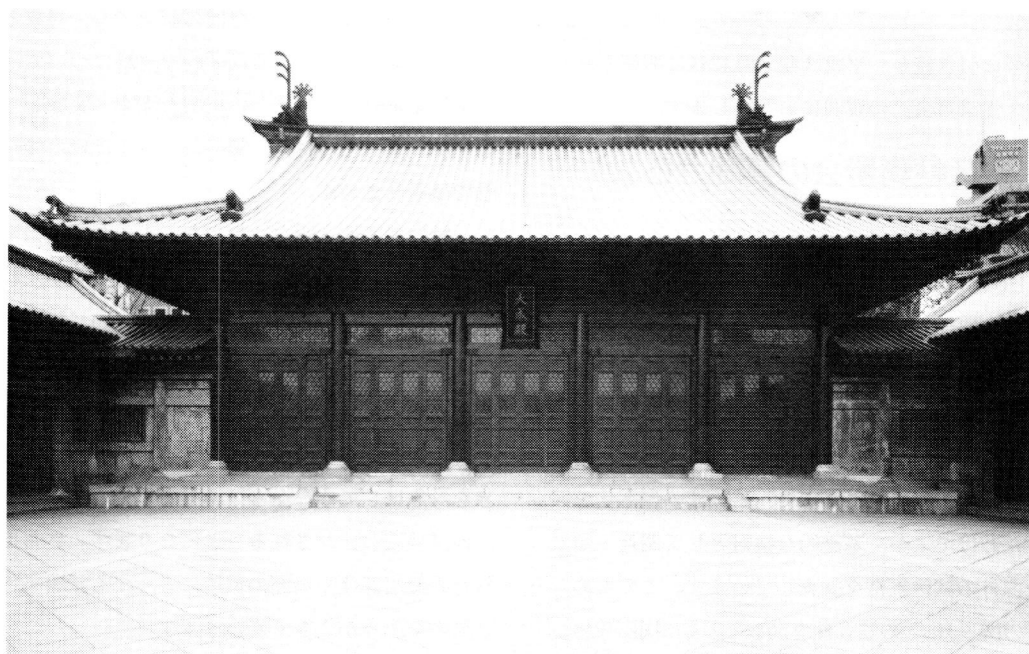
写真1 大成殿を中庭より望む。両サイドの渡り廊下は修理前。
