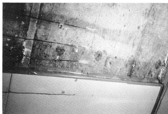
写真5 天井スラブの結露(外気 $-20^{\circ}\text{C}$ 、上階 $13^{\circ}\text{C}$ 、 $L=45\text{cm}$ )
