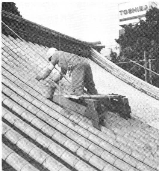
汚れの除去、緑青促進液散布
