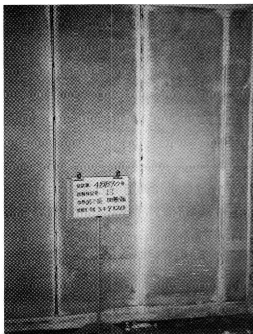
写真1 試験体記号S 加熱終了後の目地部A（中央のシーリング材）の 加熱面側の状況
