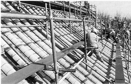
写真4 屋根銅板洗浄、人工緑青処理
