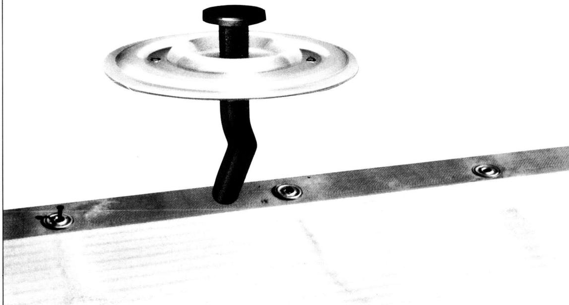
トーヨーMF法は、トーヨーCSMシートを用いた、改修・湿潤・寒冷地での防水工事に適した機械固定工法です。固定金具〈スパイク〉で防水シートを下地コンクリートに直接固定する方法ですから、接着工法に比較して●下地処理が簡易でよい●フクレが発生しない●工期が短い●経済的(物件によりますが)等の特長があります。
