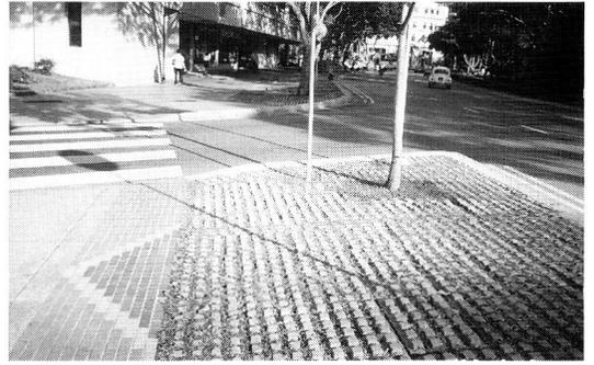
写真5 地下に雨水を浸透させる工夫を施した、環境共生を考慮したコンクリートブロックによる舗道の例。(こうした配慮も、街並みを美しく見せる)
