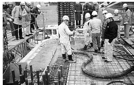
梁スラブコンクリートの打設“Kグループ”の実大施工実験
