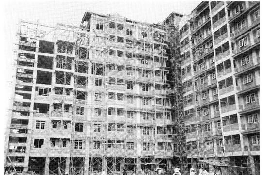
写真12 ジャカルタ市内の10階建集合住宅の建設現場（RC造、純ラーメン構造）
