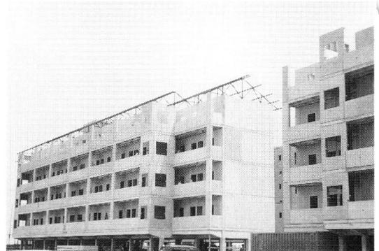
写真13 ジャカルタ市郊外の5階建集合住宅の建設現場（RC造壁式構造、1階のみRC造ラーメン構造）
