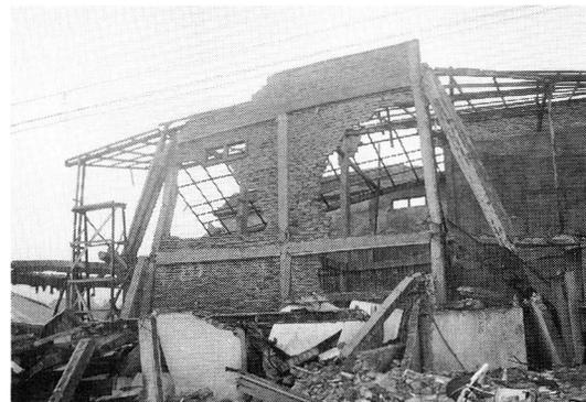
写真11 スマトラ南部リワ地震のRC2階建住宅の被害例
