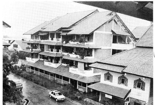
写真14 ジャワ島東部スラバヤ市の4階建集合住宅（RC造、純ラーメン構造）
