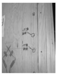
写真2 くぎの破断
