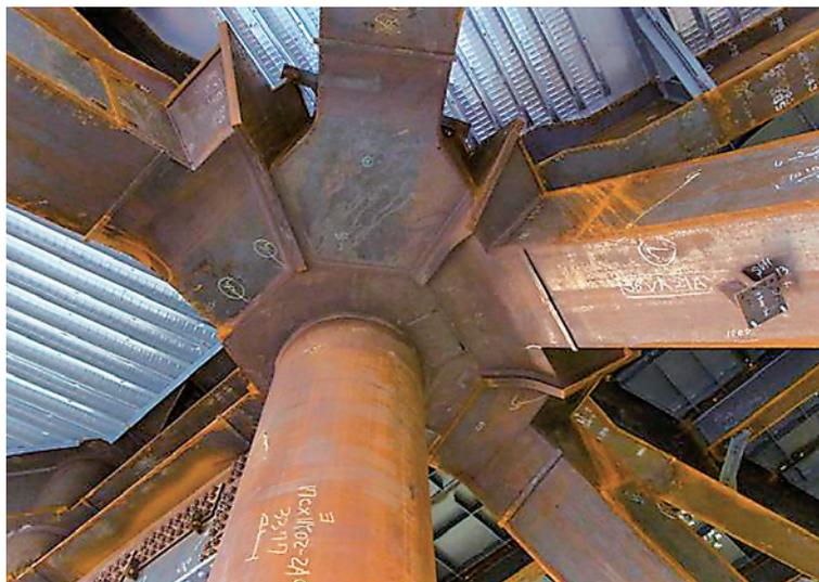
写真6 コーナー部の柱とトラス接合部の外観
