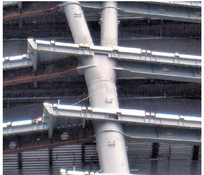
写真2 地上架構の傾斜柱交差部の仕口外観
