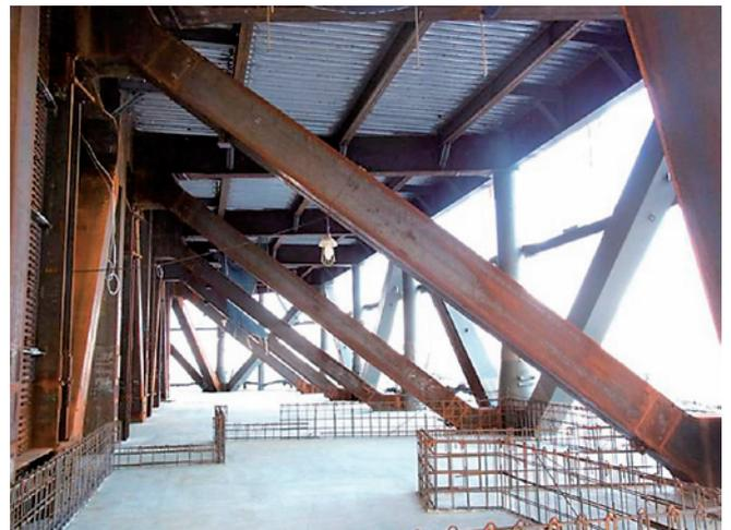
写真3 2方向に配された立体トラスの外観
