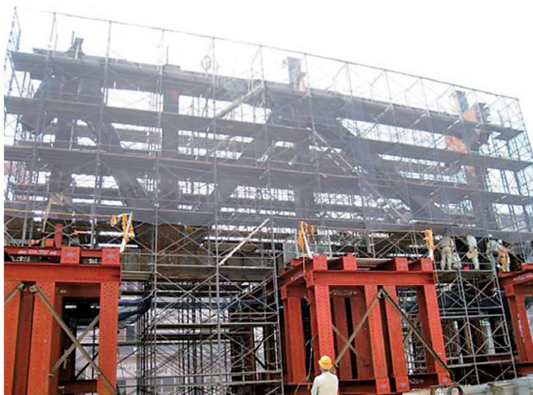
写真8 切替階鉄骨の仮組試験状況
