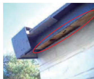
写真4 野地板裏面露出部②
