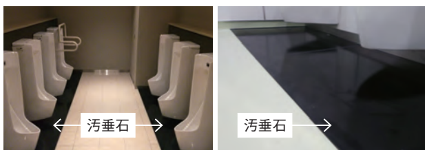
写真1 汚垂石の使用状況の一例
