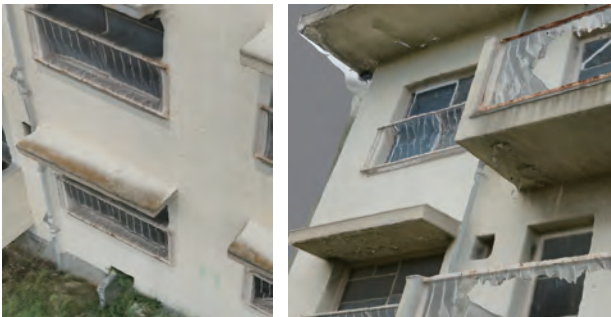
図5 ドローンで撮影した建物壁面の3次元モデル
