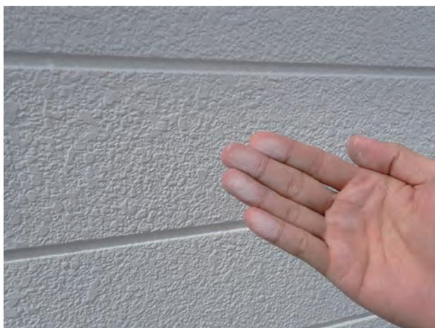
写真1 外壁塗装の白亜化(チョーキング)現象の例
