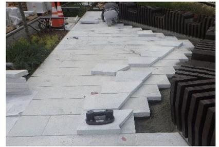
(c) コンクリート製品による舗装
