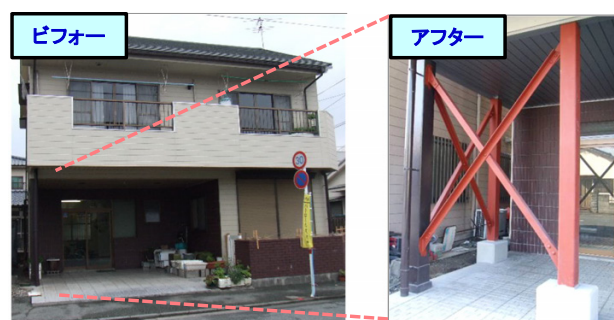
写真1 無線加速度センサで補強効果の検証をした住宅
