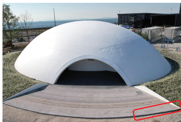
写真7 DACによるCO 2 を固定させた舗装ブロック施工箇所
