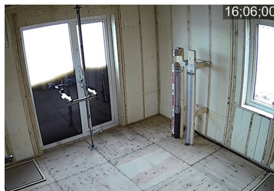
写真8 写真7と同時刻の室内の状況
