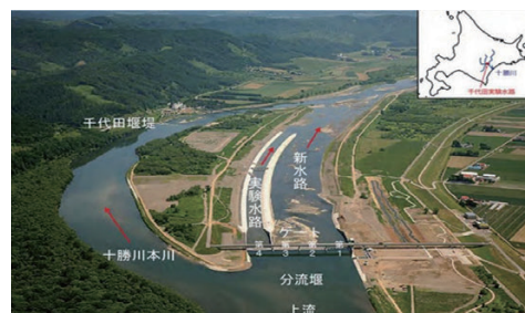
写真1 十勝川千代田実験水路の概要
