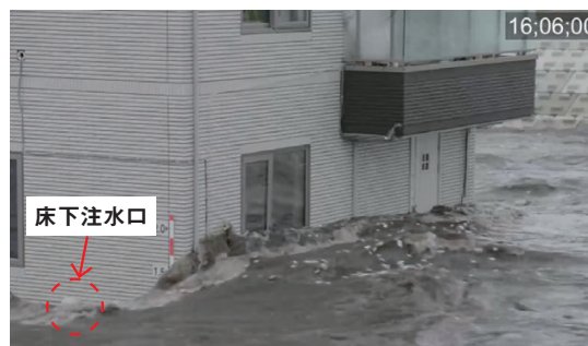
写真7 破堤3分後の状況（最高水位約1.7m、16:06:00）
