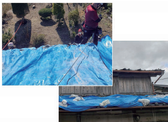
写真7 ブルーシートの固定方法の例
