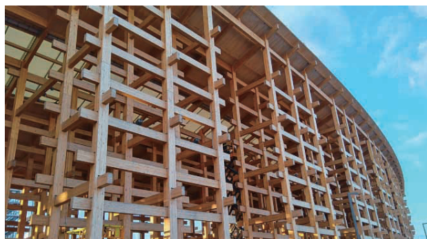
写真1 大阪・関西万博における大屋根リング
