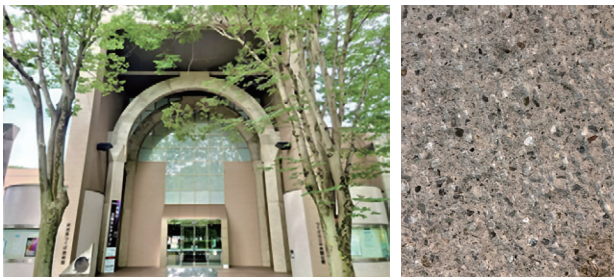
写真3 つくば文化会館アルス西側入口と外柱のはつり仕上げの例
