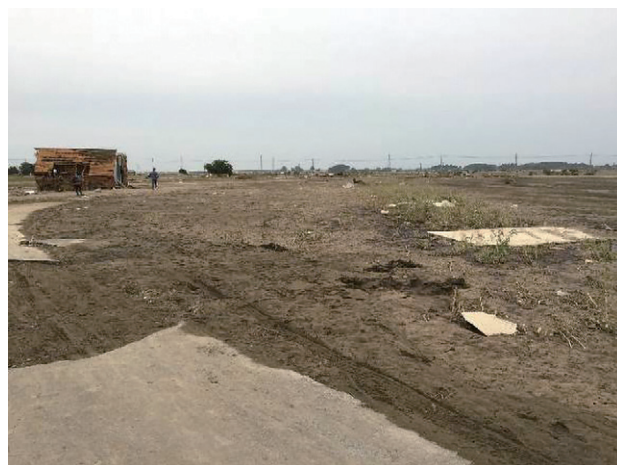
写真6 コンクリート路盤の移動
