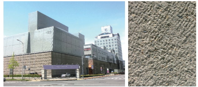
写真5 つくばセンタービル外観と外壁のこだたきの例
