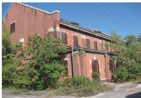
写真3 広島旧陸軍被服支廠倉庫1号館の外観（調査時）
