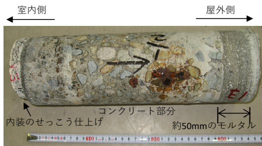
(a) 爆心地側試験体「爆1梁」の外観
