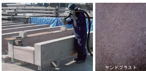
写真8 サンドブラスト作業状況と表面仕上げの状態
