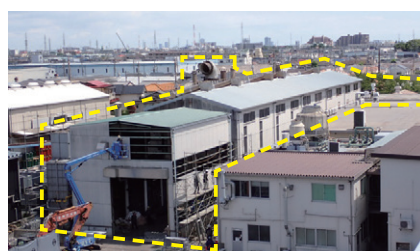
写真3 解体工事(敷地北側からの外観 2026年7月)
