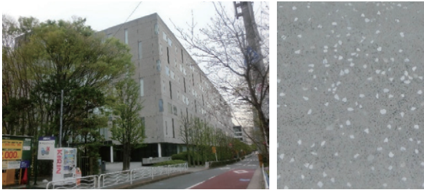
写真11 竹中工務店東京本社外観と外壁の研磨仕上げ
