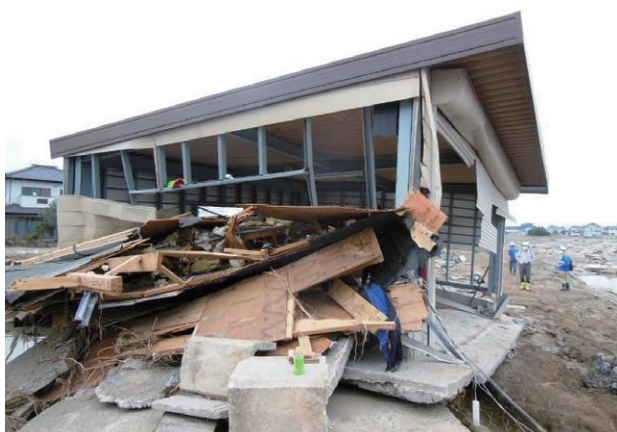
写真5 流出した倉庫の状況
