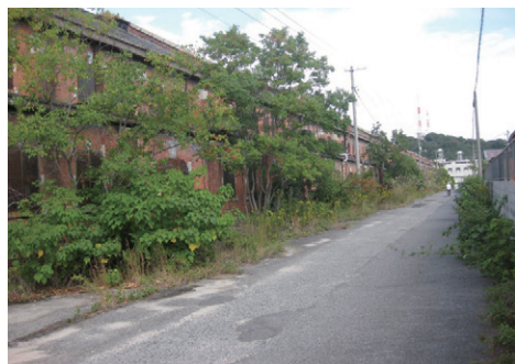
写真4 一列に並び建つ1号～3号館の外観（調査時）
