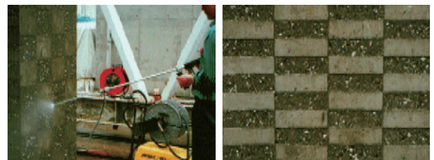
洗出し状況 洗出し完了 写真13 凝結遅延シートによる洗出し仕上げの例 (大林組提供)
