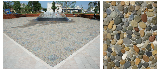
写真12 港南緑水公園と洗出し舗装板の例 (太平洋プレコン工業提供)
