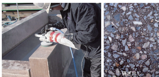
写真7 研ぎ出し作業状況と表面仕上げの状態
